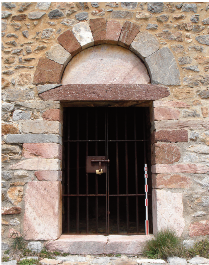
Fig. 7. Belloc (Villefranche-de-Conflent, Pyrénées-Orientales), église Saint-André ; portail ouvert à la fin du XII e siècle dans le mur gouttereau méridional. Linteau et tympan en marbre griotte. Ce marbre sombre des claveaux et des piédroits alterne avec des calcaires gris ou rose pâle cloisonnés, ici majoritaires. © Cécile Respaut.
