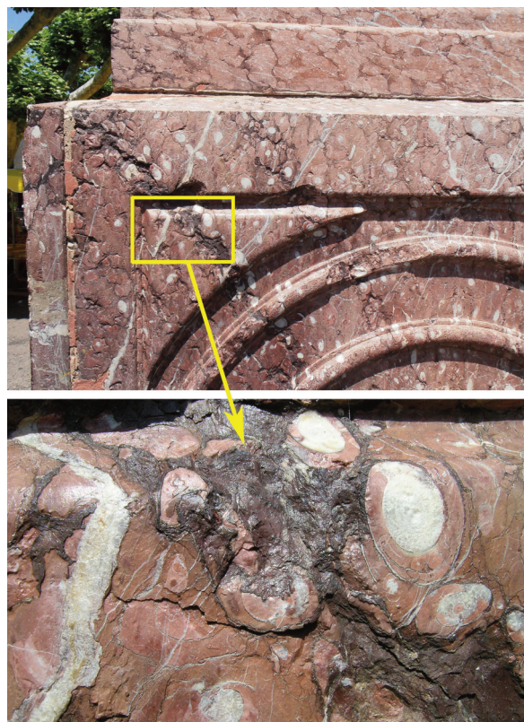
Fig. 14. Prades (Pyrénées-Orientales), fontaine en marbre griotte de la Place de la République, 1867 ; détail du panneau inférieur montrant l'assemblage des minces plaques sciées et polies, ainsi que les disgracieux filets couleur gris à noirâtre (détail sur la vue du bas). En haut, sur la plaque supérieure, une partie noduleuse plus claire et à structure en motte de ce même marbre où les fossiles sont aplatis ou digérés dans la matrice. © Cécile Respaut.
