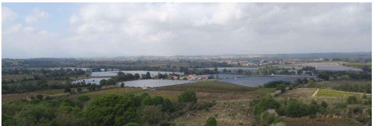
Figure 9 : La centrale photovoltaïque d'Ortaffa en Novembre 2016
