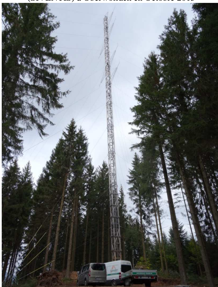
Figure 6 : La mise en place d'un mât de mesure éolien en bois par l'entreprise Kienzler (SIVENTIS) à Oberwolfach en Octobre 2015
