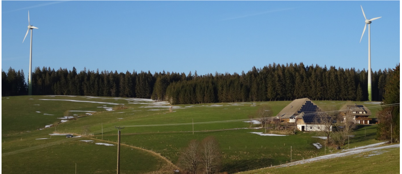
Figure 4: Les éoliennes du Grundtal à Gütenbach en Allemagne en 2014
