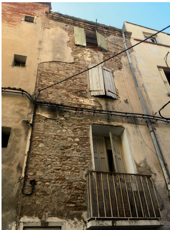
6 - Rue de l'Anguille. Façade montrant le type de construction caractéristique du 19 e siècle, maçonnerie de galets montée par hauteur de banches, séparées par un lit de briques (« cairons »).
