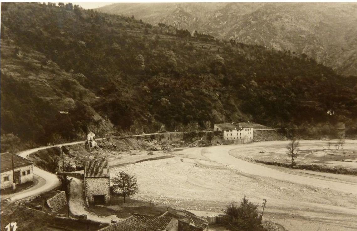
Fig 14 - Route nationale 115: remise en état au lieu-dit la Casota (Arles-sur-Tech, entre le moulin d'en Camps et le Pas del Llop) 1941. ADPO, 1443W83. On aperçoit la brèche ouverte par l'Aiguat sur la route.
