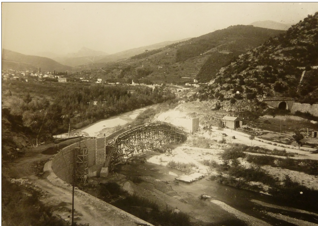
Reconstruction du Pont Neuf d'Arles-sur-Tech sur la RD 115 emporté par l' aiguat d'octobre 1940, s. d. [vers 1947]. ADPO, 111W3.
