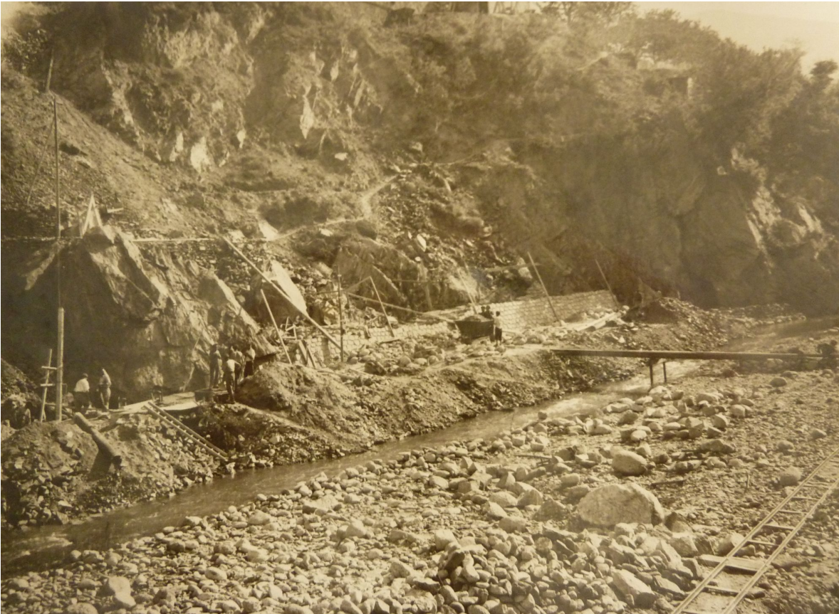
Fig 13 - Vue générale des travaux de reconstruction de la route nationale n°115, entre Céret et Amélie-les-Bains, au lieu-dit les Embaussades (Reynès), 10 septembre 1945. ADPO, 1443W2.
