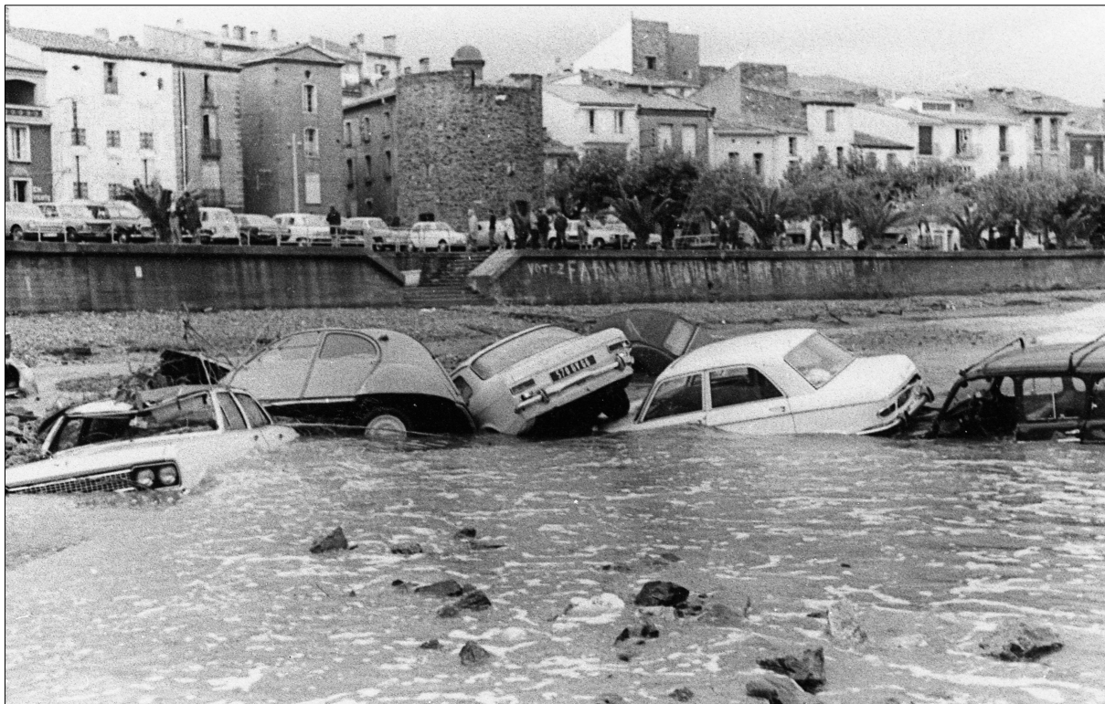
Inondation du Douy à Collioure, septembre 1971. Archives de l'association Collioure par l'image (classeur 1548).
