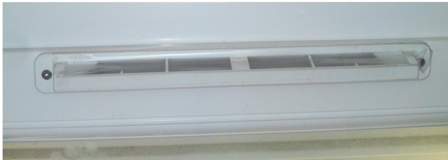
Figure 3.34 – Aérateur  $30 \text{ m}^3 \cdot \text{h}^{-1}$  PVC posé en 2001
