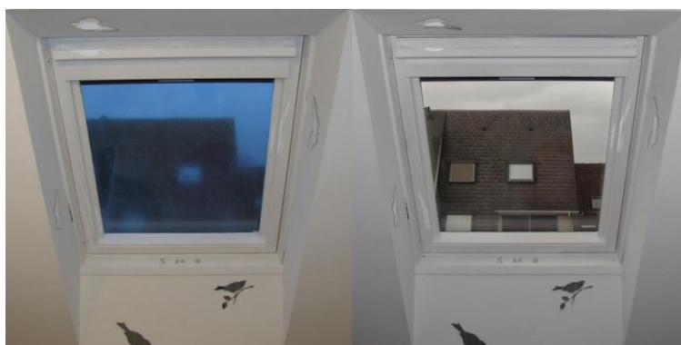
Figure 3.19 – Un cas de vitrage HS sur un VELUX
