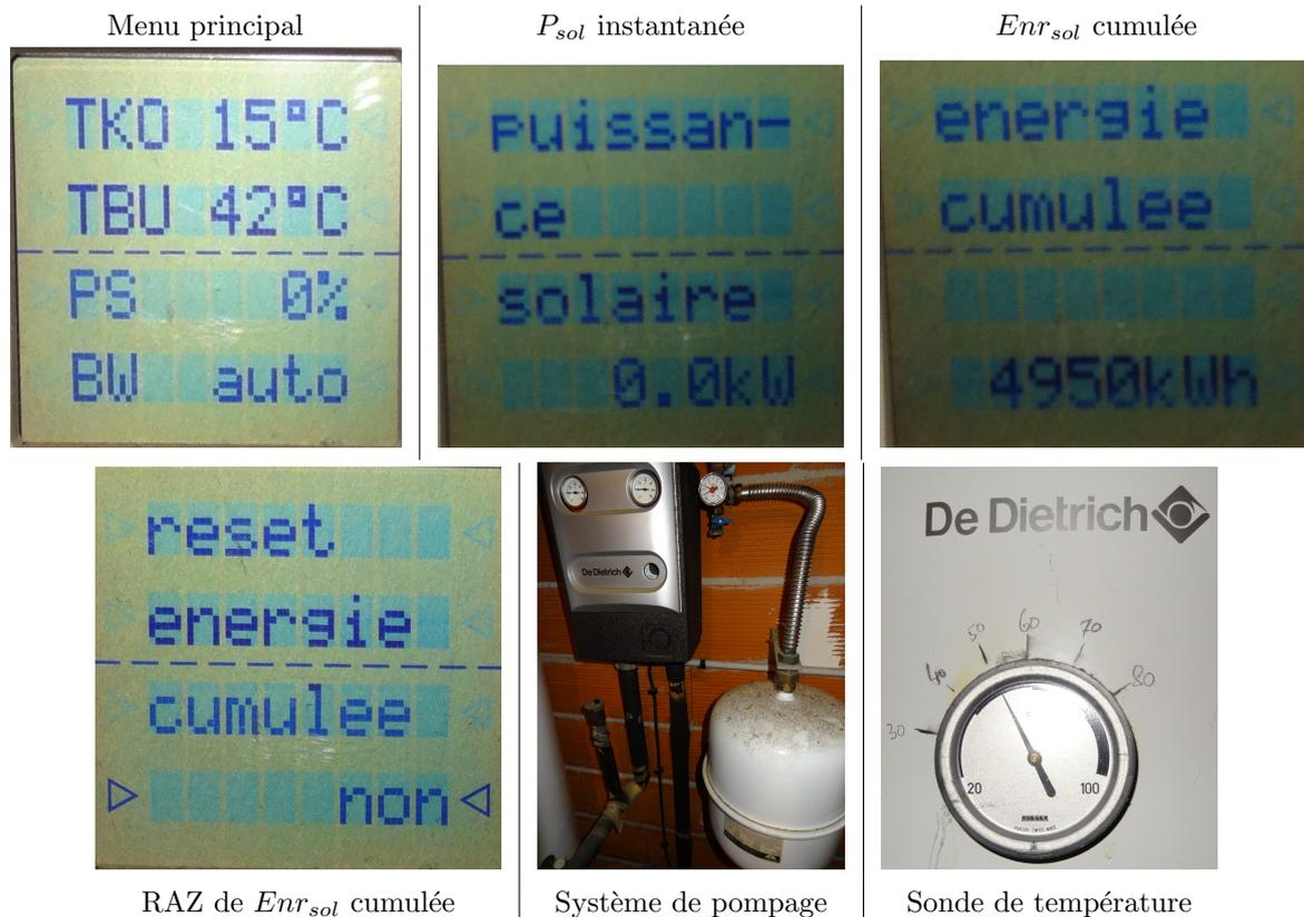
Figure 3.9 – Quelques captures d'écran du contrôleur et visuels de l'installation solaire
