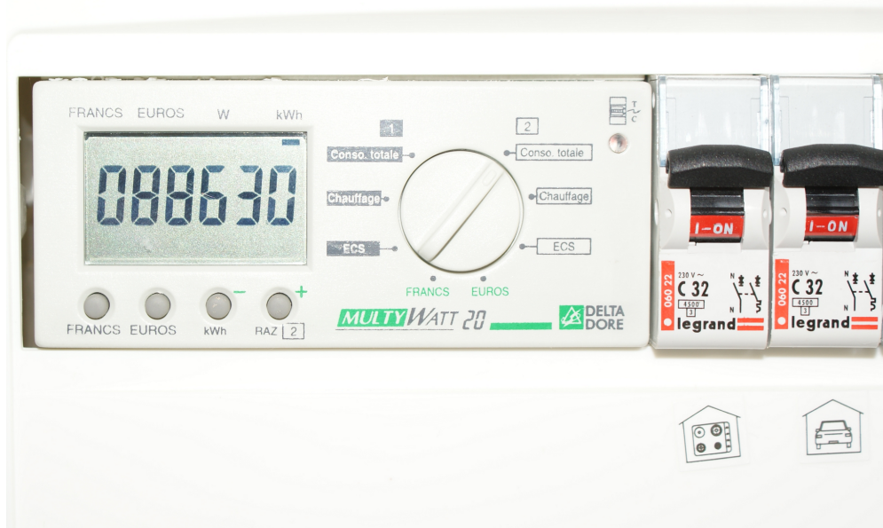
Figure C.1 – Le multywatt 20 présent dans le tableau électrique du modèle n°22
