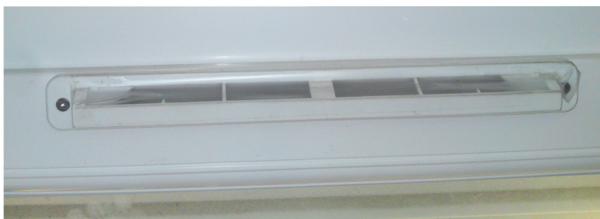
Figure 3.34 – Aérateur 30\text{ m}^3.h^{-1} PVC posé en 2001
