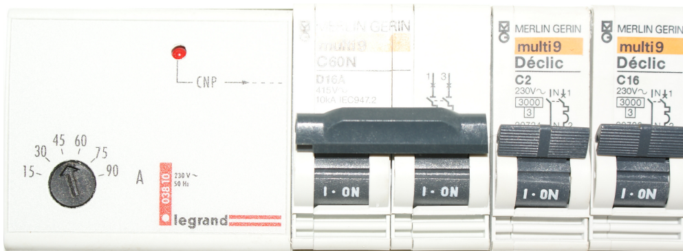
Figure C.2 – Un délesteur de puissance couplé au multywatt20 présenté ci-dessus
